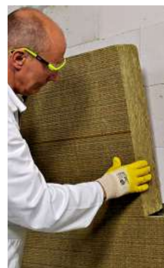
Eine Dämmung der Gebäudehülle ist ein wichtiger Beitrag zum Klimaschutz und zum Energiesparen.
