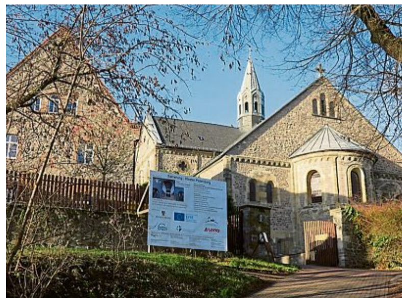
Ein Bauschild weist auf die Arbeiten an der Kirche hin.
