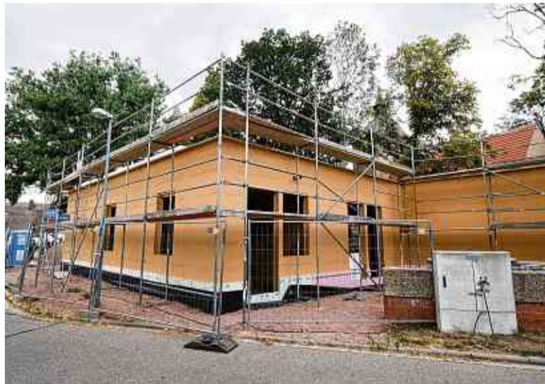
Das offene Haus für Begegnungen im Rohbau
