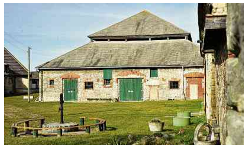
Das pagodenartige Dach des Schafstalls sorgt für die Belüftung.
