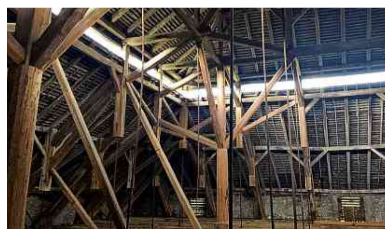
Tolle Holzkonstruktion: Der Hängeboden hängt direkt am Dach.
